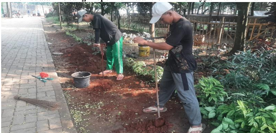
Gambar IV. 6. Pembuatan Lubang Biopori di Pesantren Al Ashriyyah Nurul Iman
