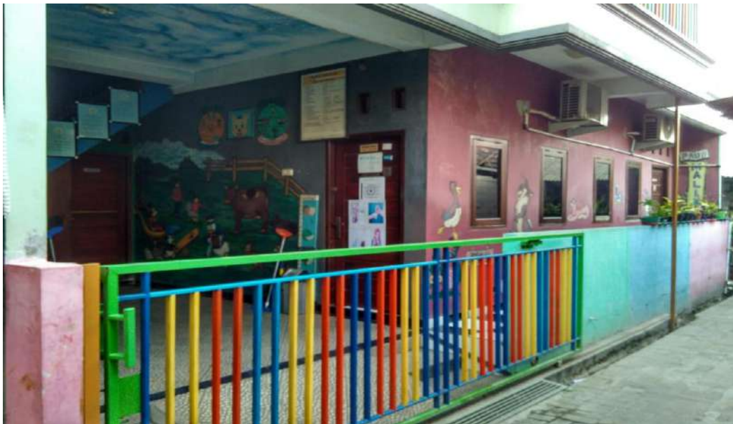
Gedung sekolah PAUD Terpadu Malikah
