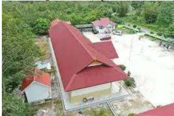
Gambar III: 4. Gedung Sekolah. Sumber: ciptakarya.pu.go.id
